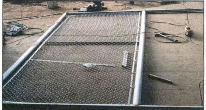
Foto 8. Instalación de malla y tubos galvanizados
