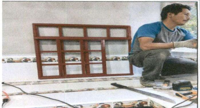
Foto 2: Sustitución de ventana de madera
