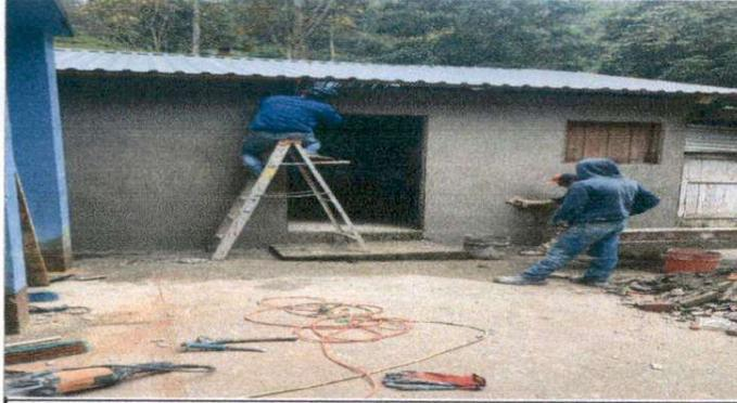
Foto 7. Reparación de repello y cernido de pared
